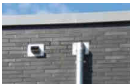
Przykładowy wygląd zamontowanego odwodnienia głównego i awaryjnego
